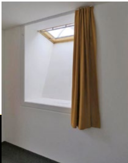
Neu bei KNECHT: Variante kleiner Lichtfluter, viel Licht und ein neues Raumgefühl inklusive. Das Fertigteil wird selbstverständlich vor Ort abgedichtet und gedämmt.
