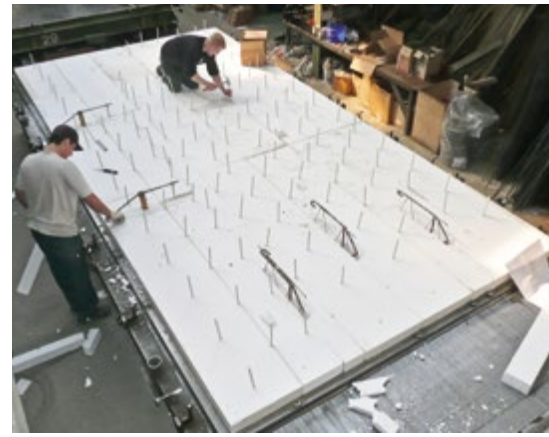
Einsetzen der Thermoanker in die Wärmedämmung
