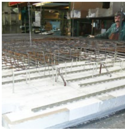
Einbringen weiterer Bewehrungslagen
