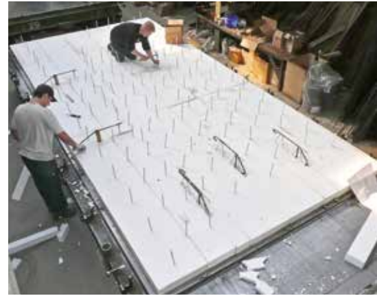
Einsetzen der Thermoanker in die Wärmedämmung
