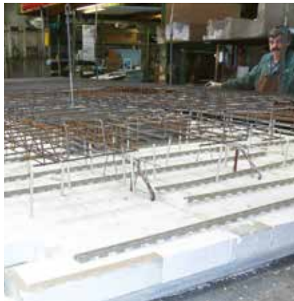
Einbringen weiterer Bewehrungslagen
