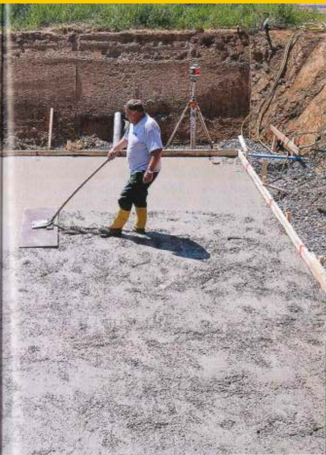
Im letzten Schritt wird die Oberfläche der Betonschicht geglättet. Danach muss sie ruhen und aushärten. Auf der Bodenplatte kann noch eine Dämmschicht verlegt werden.
