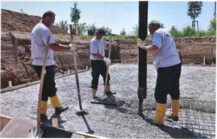
Anfertigung der eigentlichen Bodenplatte: Der Beton wird angeliefert, auf die Fläche gegossen, verteilt und anschließend verdichtet.
