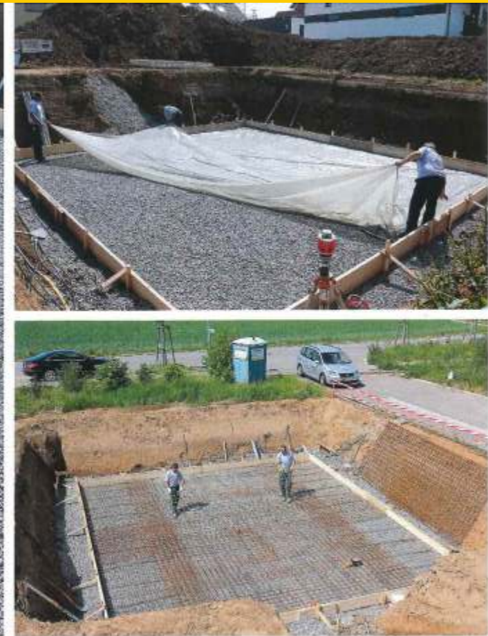
Die Bauarbeiter verlegen Abwasserrohre in das Kiesbett, decken die Sauberkeitsschicht mit Folie ab und legen Stahlmatten als Bewehrung für den Beton aus. Unter dem Beton könnte noch eine Dämmschicht gelegt werden.
