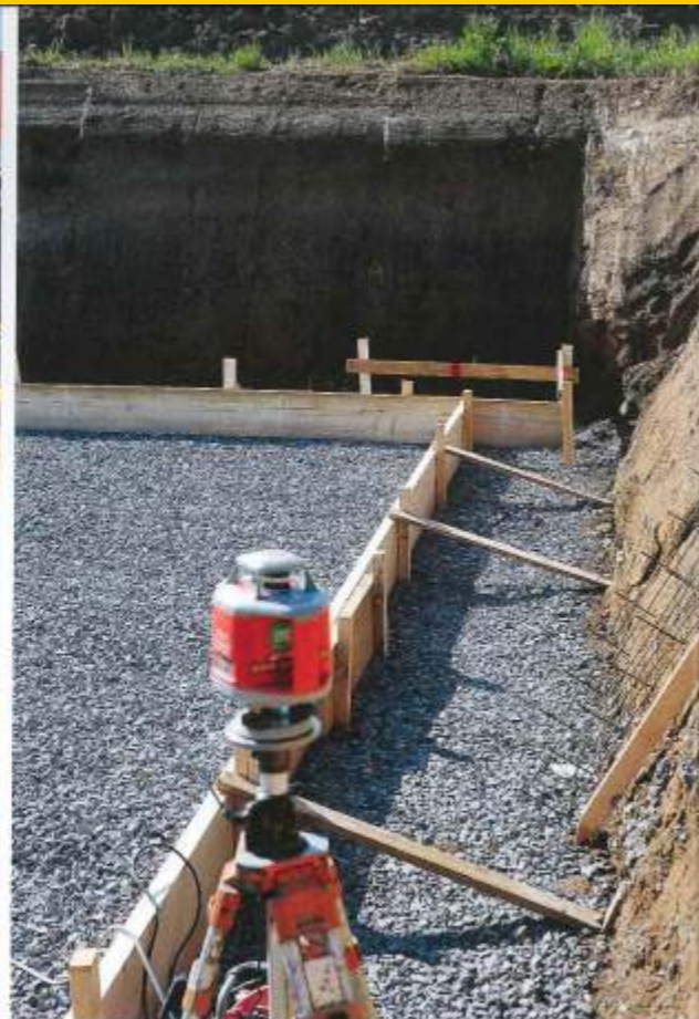
Erste Schritte zur Anlage einer Bodenplatte: Nach dem Aushub wird als Abgrenzung zum Erdreich eine Sauberkeitsschicht aus Kies verlegt.
