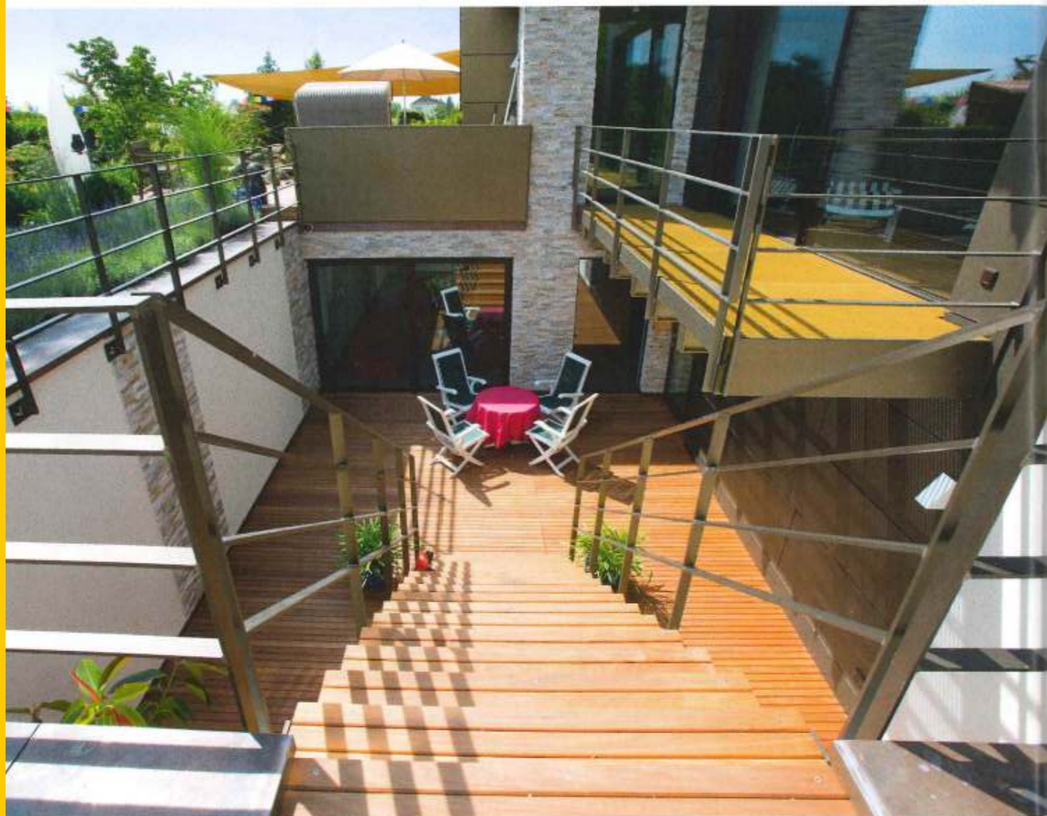
Dieser schön gestaltete Lichthof ermöglicht bodentiefe Fenster für maximalen Tageslichteintrag in die Kellerräume, gleichzeitig schafft er eine sonnige, uneinsehbare Terrasse. Glatthaar
