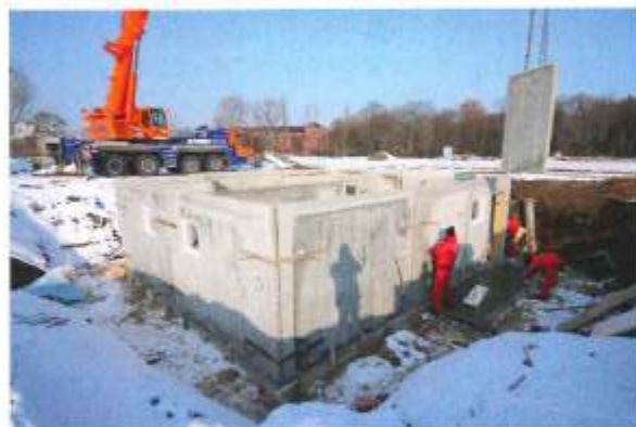
Ein Fertiggkeller wird witterungsunabhängig im Werk hergestellt. Fertiggkeller können auch im Winter gebaut werden. Dadurch kann sich die Bauzeit verkürzen.
