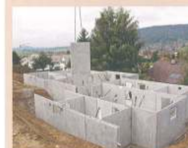
Aus den im Werk vorgefertigten Betonteilen wird der Keller vor Ort in kürzester Zeit montiert.
