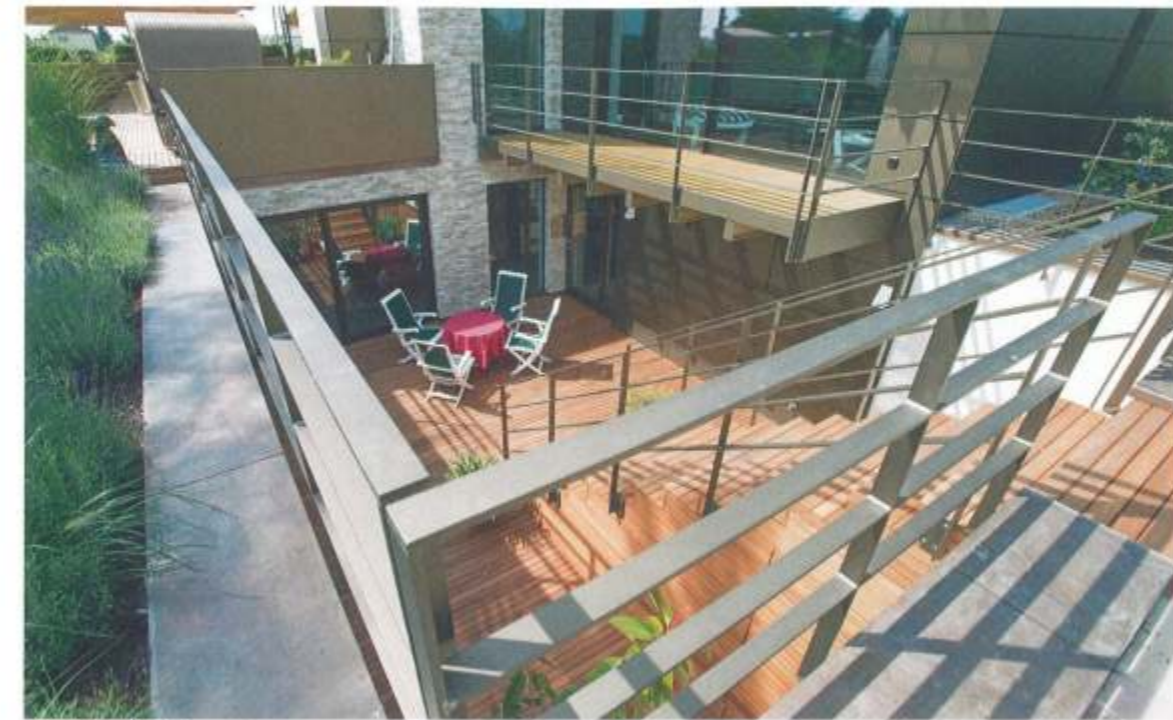
Hier erhielt die Einliegerwohnung im Untergeschoss eine großzügige Verglasung für reichlich Tageslicht und einen geschützten Lichthof als Freisitz. Glatthaar
