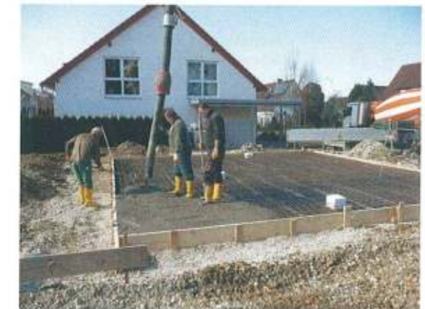
Auf die durchgehende Stahlbewehrung wird der Ort beton aufgebracht. Knecht
