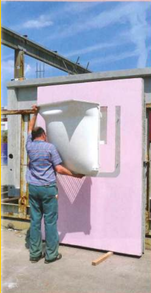
Vor Ort wird der Lichtschacht direkt aufgebracht und mit einer vorgefertigten Dämmung rundum warm eingepackt.
