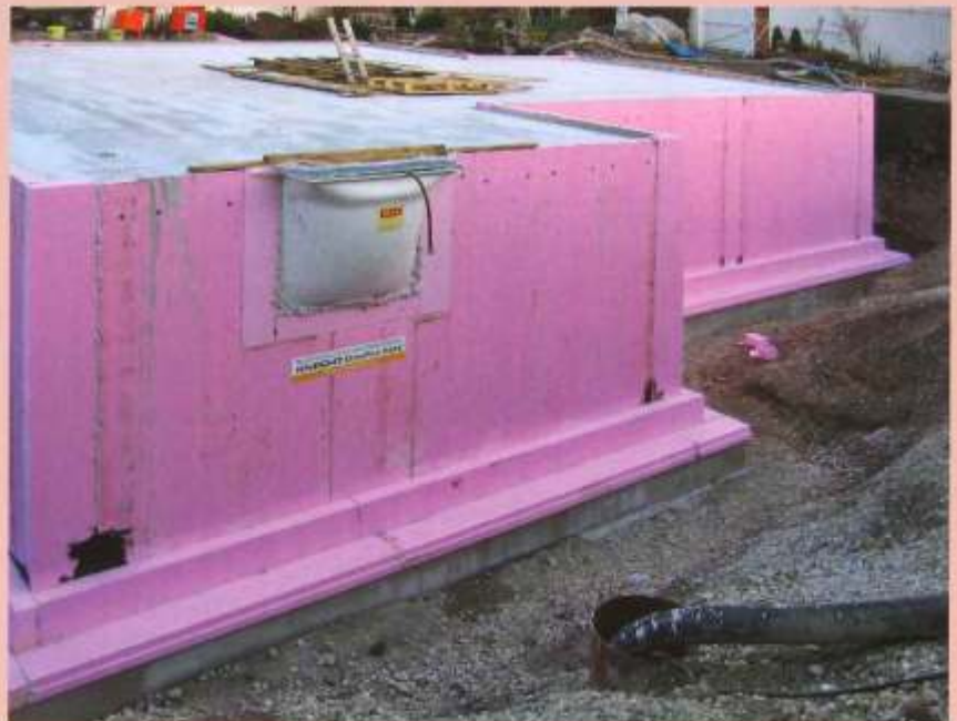
Vor Ort wird der Lichtschacht direkt aufgebracht und mit einer vorgefertigten Dämmung rundum warm eingepackt.
