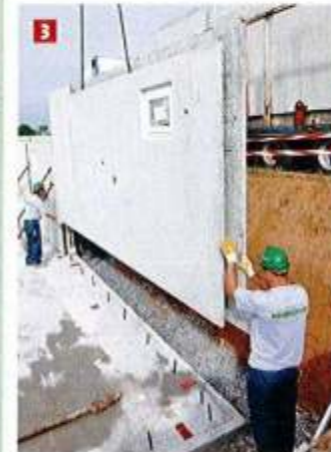
3 Die Außen- und Innenwände sind maßgenau vorgefertigt und werden auf der Baustelle eingepasst. Besonders hochwertig ist die KlimaPlus Wand mit werkseitig angebrachter Außendämmung
