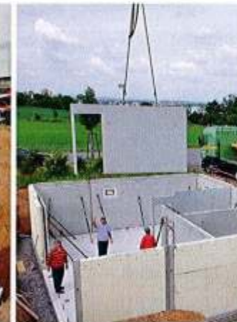
3 Die Außen- und Innenwände sind maßgenau vorgefertigt und werden auf der Baustelle eingepasst. Besonders hochwertig ist die KlimaPlus Wand mit werkseitig angebrachter Außendämmung
