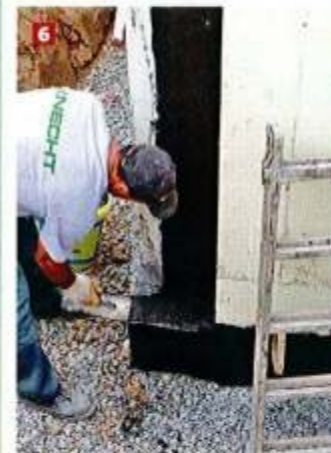
6 Nun werden die Außenfugen abgedichtet. Im Anschluss muss lediglich noch die Wärmedämmung im Fugenbereich angebracht werden
