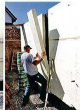
6 Nun werden die Außenfugen abgedichtet. Im Anschluss muss lediglich noch die Wärmedämmung im Fugenbereich angebracht werden
