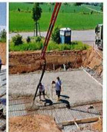
2 Bei der Vorbereitung des Grundstücks werden zuerst die Entwässerungsleitungen und -anschlüsse verlegt. Dann wird die Bewehrung eingebracht, ehe die Fundamentplatte betoniert werden kann
