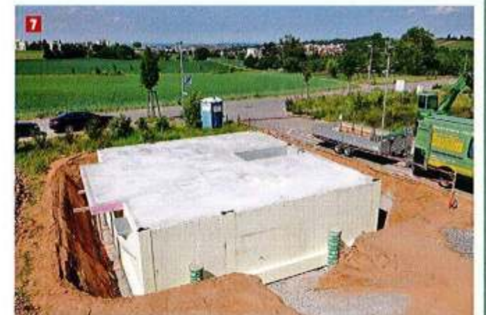
7 Der Fertigteilkeller ist fertig. An der Schnittstelle zwischen Keller und Haus wurden alle nötigen Anschlüsse exakt aufeinander abgestimmt. Für einen Keller dieser Größe beträgt die Bauzeit vier bis fünf Tage
