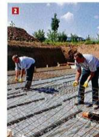
2 Bei der Vorbereitung des Grundstücks werden zuerst die Entwässerungsleitungen und -anschlüsse verlegt. Dann wird die Bewehrung eingebracht, ehe die Fundamentplatte betoniert werden kann
