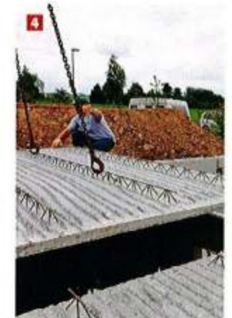
4 Maßarbeit: Die passgenauen Deckenelemente bilden den Abschluss der Montagearbeiten
