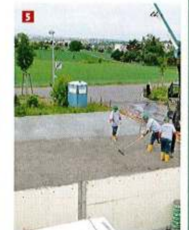
5 Die Decke erhält eine Bewehrung, dann werden Außenwände und Kellerdecke mit Beton verfüllt
