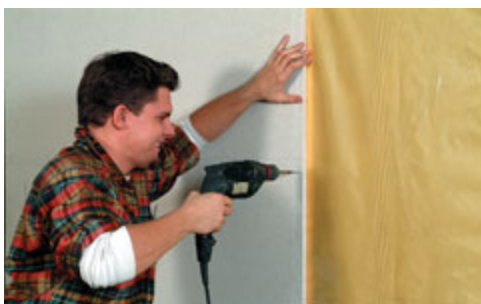
Step 5: Die Gesamtkonstruktion wird mit Gipskarton-/Gipsfaserplatten beplankt.
