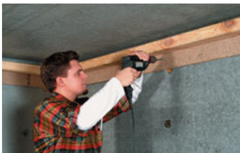
Step 1: An Decke und Boden werden die Konstruktionshölzer mit dem Schrauber befestigt. In der Wand bereits werkseitig integrierte Montagepads erleichtern das Verschrauben.
