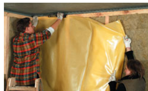
Step 4: Über der Dämmung wird eine Folie als Dampfsperre befestigt.
