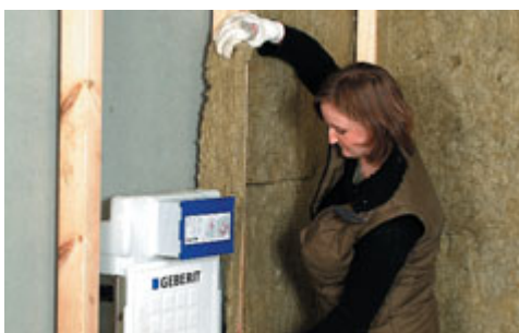
Step 3: Erforderliche Installationssysteme und -leitungen oder Sanitärblöcke sowie Fensteröffnungen sind einfach zu integrieren.
