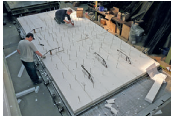
Einsetzen der Stäbe in die Wärmedämmung
