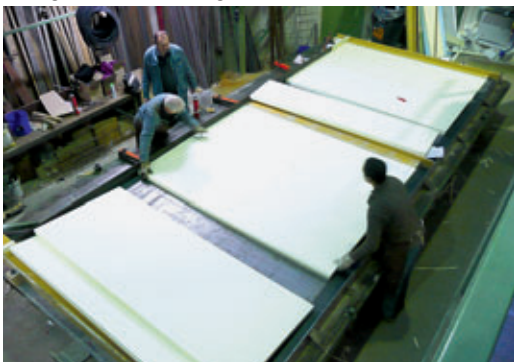
Einlegen der Dämmung im Werk
