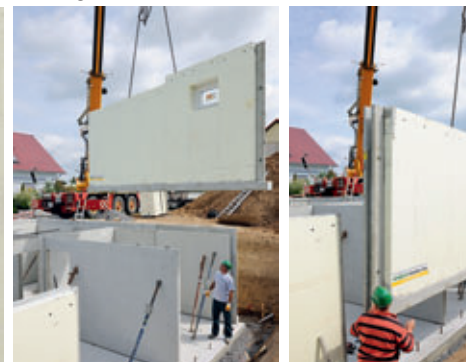
Montage der Wandelemente
