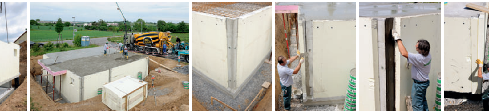
Schließen und Abdichten des Fugenbereichs
