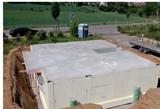
Durchgängig gedämmter Keller
